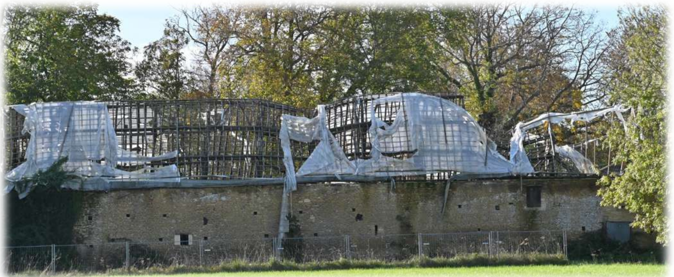
Bâtiment de l'ancienne ferme du Breuil Luronium
